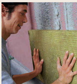
Die Dämmplatten werden dann direkt in das frische Mörtelbett gedrückt.
