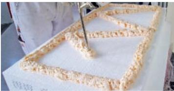
einA WDVS-Klebeschaum in einer umlaufenden Wulst mit eingeschlossenem M / W auf die Dämmplatte auftragen. Im angedrückten Zustand muß ein Klebeflächenanteil von mind. 40% erreicht werden.
