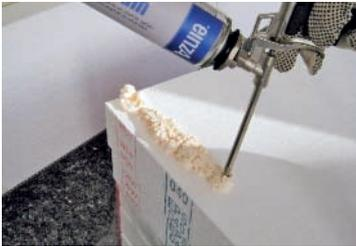
Die Dose fest auf das Pistolengewinde aufschrauben und mit der Pistole nach unten ca. 30 x kräftig schütteln. Mit der Pistolenstellschraube den Klebstoffstrang auf ca. 30 mm Durchmesser justieren.
