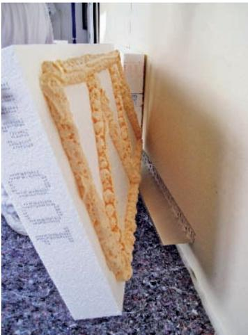
Nach ca. 10 bis 15 Minuten die verlegten Dämmplatten mit einer langen Wasserwaage nachjustieren, um eine eventuelle Nachexpansionen des Klebers zu korrigieren.
