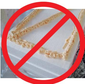
einA WDVS-Klebeschaum in einer umlaufenden Wulst mit eingeschlossenem M / W auf die Dämmplatte auftragen. Im angedrückten Zustand muß ein Klebeflächenanteil von mind. 40% erreicht werden.
