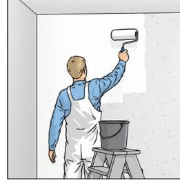
ERFURT-Systemkleber SR 2 mit einer Rolle in einer Breite von 1-2 Bahnen satt und gleichmäßig auf den Untergrund auftragen.
