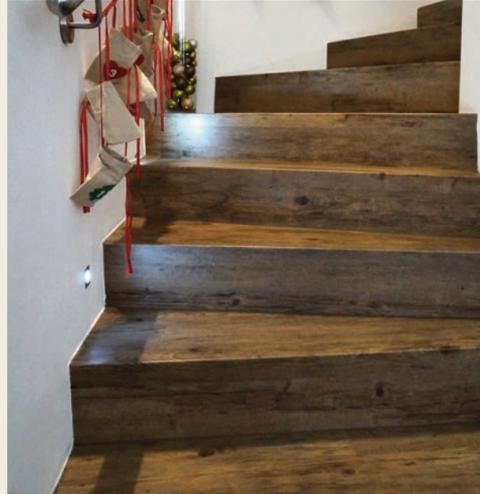
Die Treppenkanten werden aus dem jeweiligen Maß der Planken/Dielen hergestellt. Ist die Stufe breiter, wird eine weitere Treppenkante angepasst/angeklickt. Dies gilt ebenso bei tieferen Treppenstufen und ggf. bei den Setzstufen. Die Montage erfolgt vor Ort.
